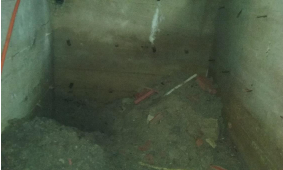
Fig. n°5 : Vue générale de la reconnaissance de fondation RF2 (source GEOTEC, octobre 2017)
